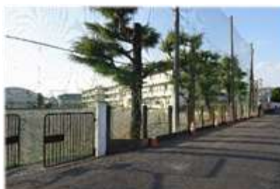
※コンクリート塀は既に撤去
